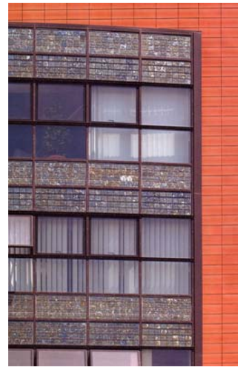
Schüco International Italia Particolare della facciata fotovoltaica
