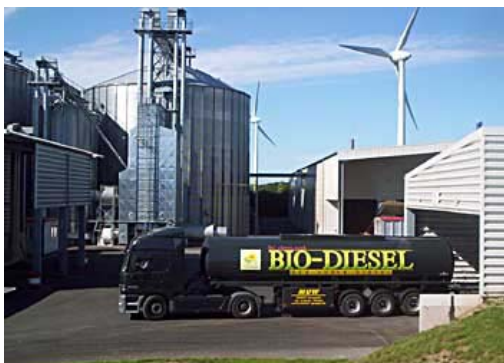
Impianto di produzione di Biodiesel in Germania
