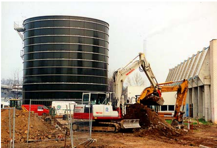
Il serbatoio d'acqua (in costruzione) contenente il freddo.
