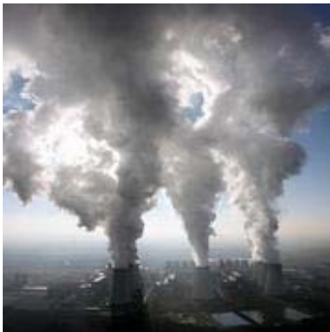
DDP Centrale termoelettrica a lignite in Germania
