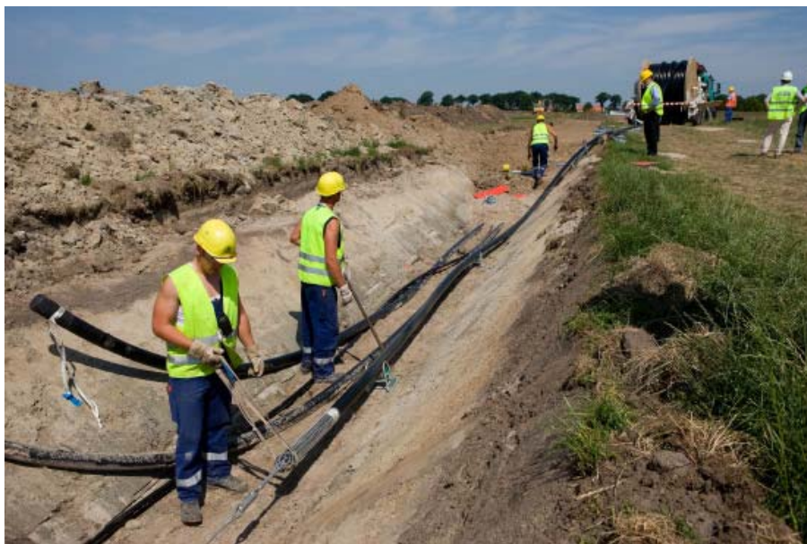
Posa di cavi per corrente continua
