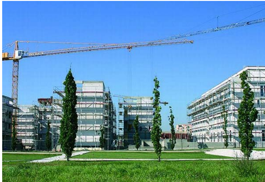
Palazzi residenziali in costruzione
