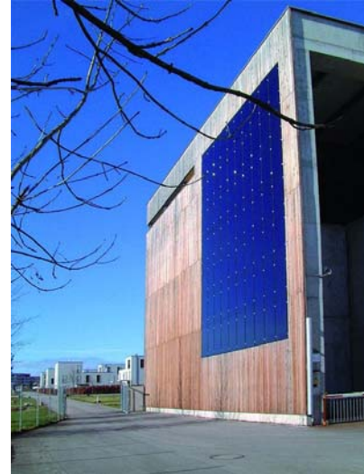
La centrale di cogenerazione del quartiere.
