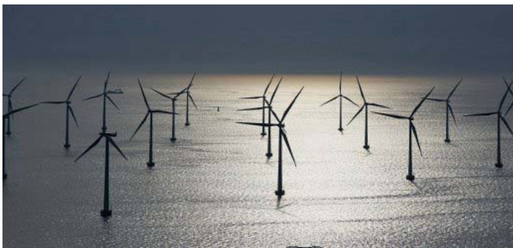
Turbine Siemens nel Mare del Nord
