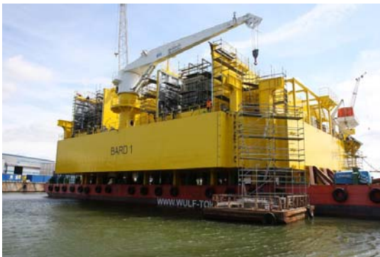
BARD-Gruppe La piattaforma con i trasformatori e gli alloggi degli operai.
