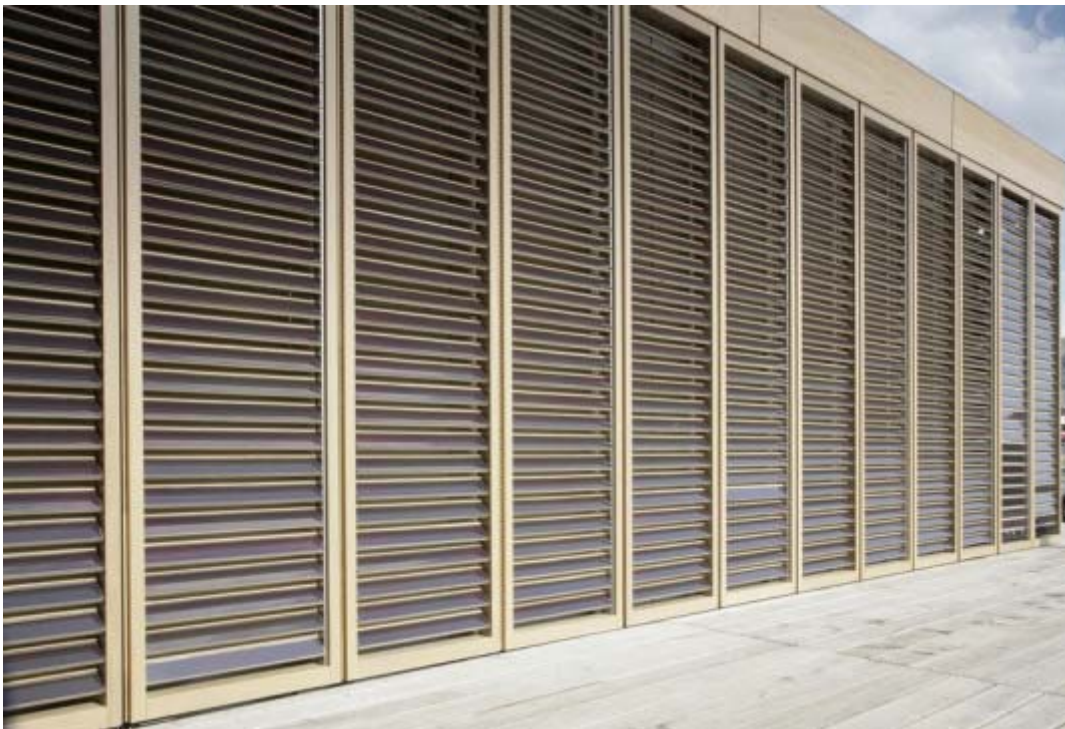
La facciata con le lamelle regolabili di legno ricoperte con moduli FV a film sottile
