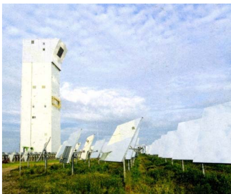
Centrale termosolare di Jülich: La torre con il receiver
