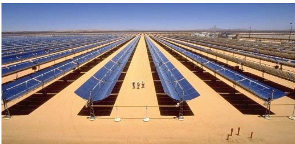
Centrale termosolare con specchi parabolici
