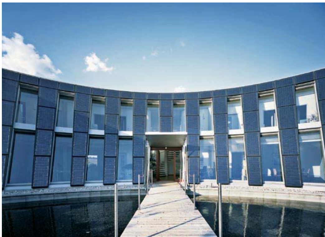
Facciata sud dell'edificio amministrativo
