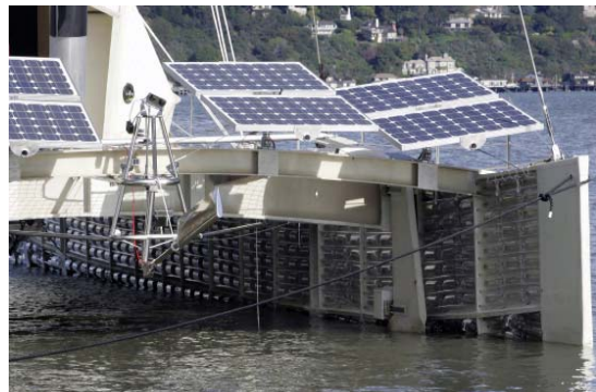
L'impianto fotovoltaico che fornisce l'energia elettrica. dpa
