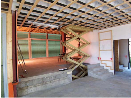
Il montacarichi usato nella costruzione è stato integrato nella villetta
