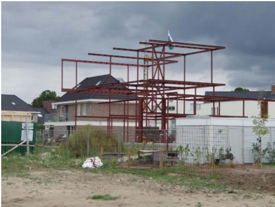
2012 Architecten Lo scheletro della villetta costruito con gli elementi della macchina tessile
