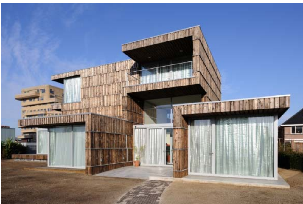
Villa Welpeloo vista dal lato del giardino
