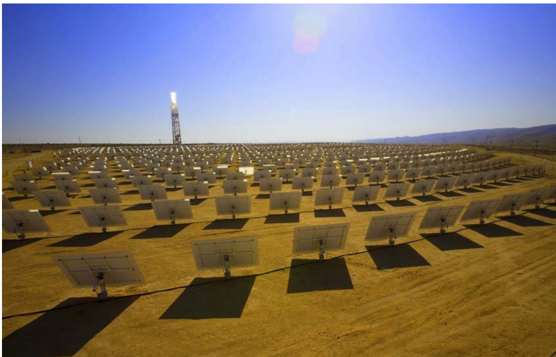
Centrale termosolare a torre nel deserto del Negev
