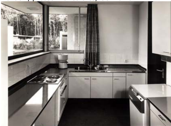
Quartiere residenziale a Mörfelden-Walldorf, presso Francoforte, Germania: una cucina
