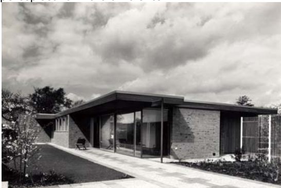
Una casa del quartiere residenziale a Quickborn, presso Amburgo, Germania
