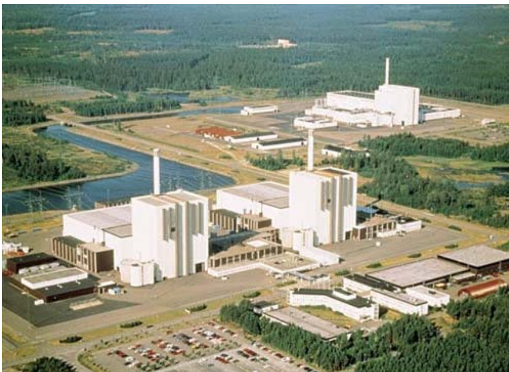
Centrale nucleare di Forsmark (Svezia)
