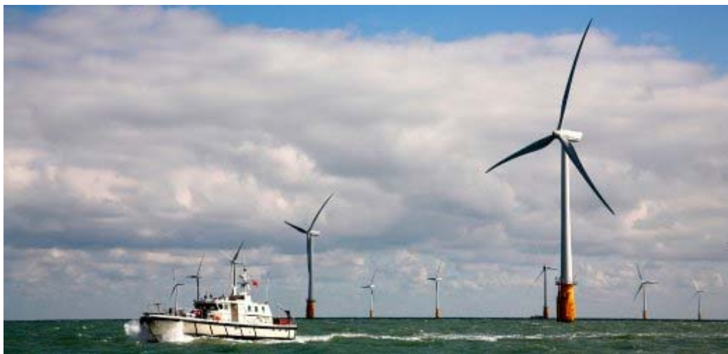
Il windpark offshore Thanet produce elettricità con una potenza di 300 Megawatt
