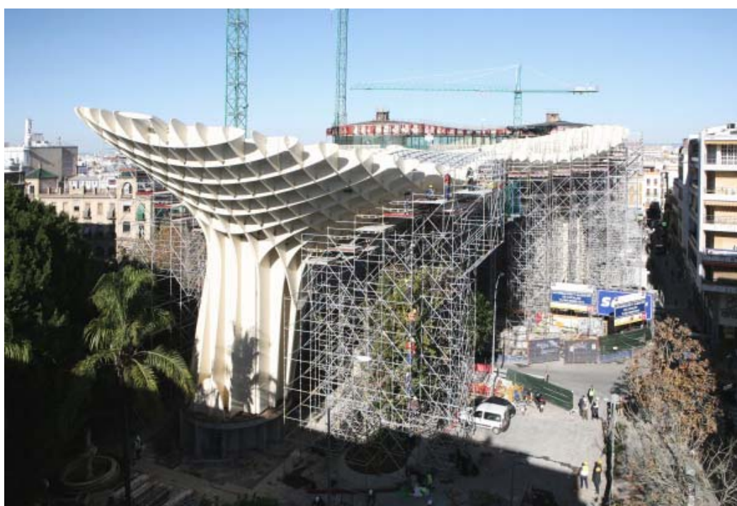
I "parasoles" in costruzione
