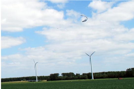
Un aquilone dirigibile e due turbine eoliche
