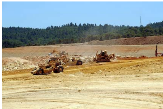
AFP Spianamento dell'area sulla quale dovrà sorgere l'impianto.
