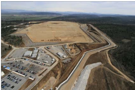
Agence ITER France Il cantiere dell'ITER visto dall'aereo. L'area è stata già spianata e nel luglio prossimo dovranno iniziare i primi lavori di costruzione.
