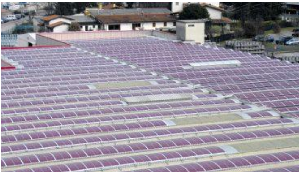
Le celle fotovoltaiche a film sottile sono flessibili e possono essere applicate su superfici ricurve. Flexcell
