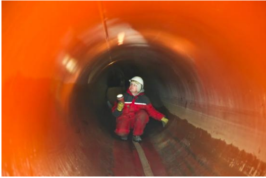
Ispezione dell'interno di un gasdotto.
