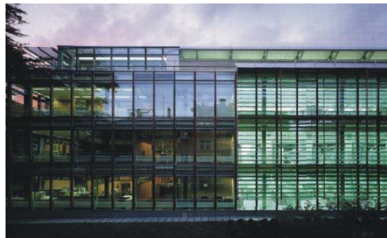
Facciata Sudest della clinica A sinistra: gli uffici con le tende a lamelle inserite tra i vetri a destra: la clinica con lamelle di vetro all'esterno
