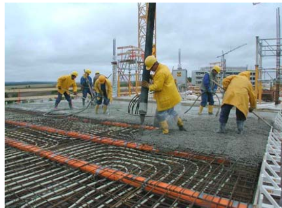
Solaio in costruzione
