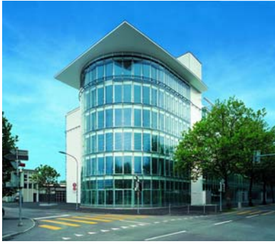
La torre con la scala
