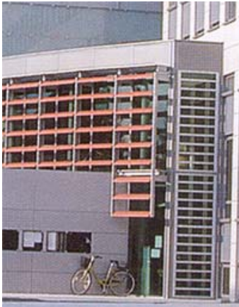
Lamelle metalliche davanti il foyer
