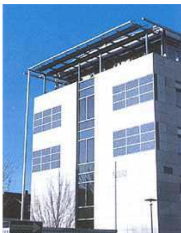
Pannelli fotovoltaici integrati nella facciata
