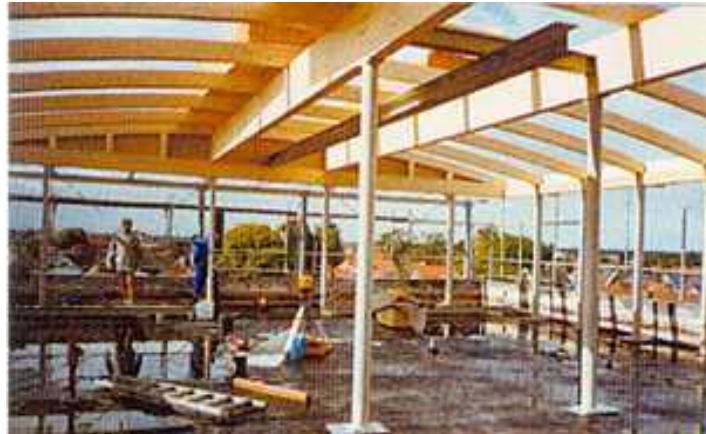
Quinto piano in costruzione
