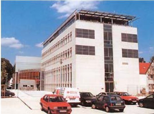
Il municipio ristrutturato ed ampliato
