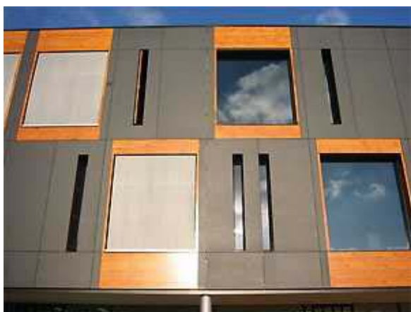
Particolare della facciata
