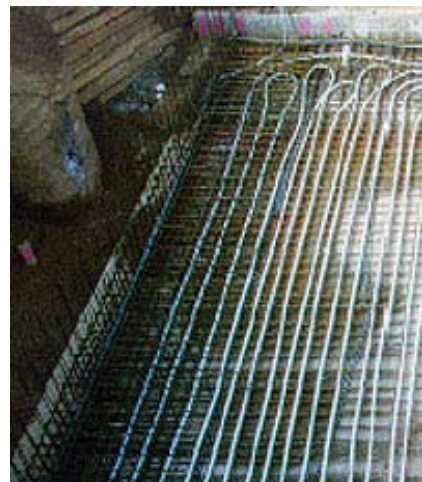
Solaio termoattivo in costruzione
