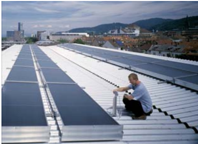
Figura 2 - I collettori solari ad aria sul tetto dell'edificio
