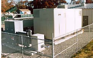
Cella a combustibile PAFC della società ONS
