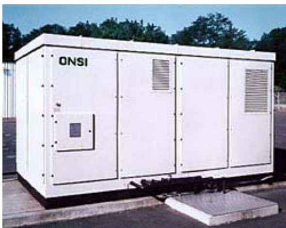
Centrale di cogenerazione alimentata con gas metano con cella a combustibile e una pompa di calore ad assorbimento
