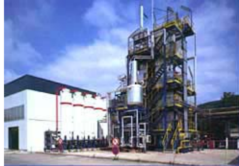
Reformer a vapore acqueo della ditta KTI
