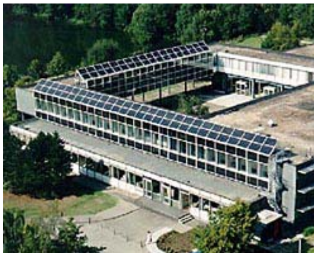
Progetto PHOEBUS – Centro di ricerca Jülich (Germania) Combinazione fotovoltaica – elettrolisi - cella a combustibile. Impianto dimostrativo per l'approvvigionamento autonomo con energie rinnovabili
